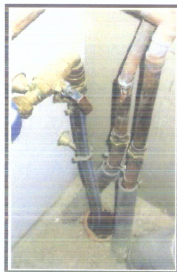
Calfeutrage des entrées de réseaux
